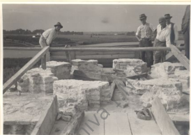
1. Resturile țurlei prăbușite găsite când s-a dărânat țurlea reconstruită. În plan s-au găsit toate elementele pentru reconstruire. S-au descoperit cărămidile de format special care alcătuiesc colonetele de la unghiuri și în situ, țigilele care acopreau baza pătrată a țurlei.
