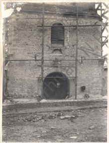
1. Clopotnița mănăstirii Fațada vest în timpul lucrărilor din 1939. Se vede forma originală a ferestrei micșorată în timpul restaurării terminată în 1910
