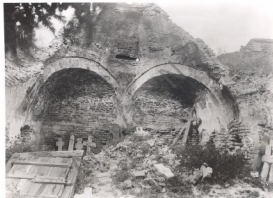
1. Biserica, după cutremur. Detaliul trecerilor și locul grinzilor de lemn înscute în zidărie
