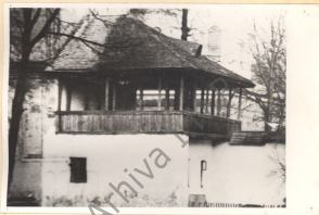
L 2 Felgerul de lângă clopotniță înainte de incendiu. Copie mărită, după care s-a executat restaurarea din 1939. Se vede că încăperea închisă nu există, ea a fost cerută de înaltele făruci bisericăști în scopuri utilitare
