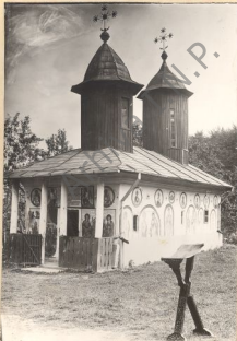
1. Vedere dinspre sud-vest
