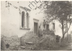
2. (1278) Ușa și ferestrele de piatră ale parterului, spre curte.
