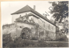
1. (1930) Văzută partea monumentală. În dreapta se vede ruina unui corp de cămin (care încă există.)
