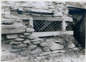
1. Detaliu de zidărie
