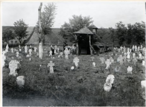
1. Vedere dinapre vest. Se vede cum prin lunecare pămîntul a îngropat altarul.
