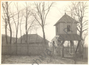
1. Vedere din exterior
