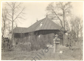
1. Vedere dinspre sud-est
