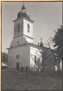
1. Vedere dinspre sud-vest
