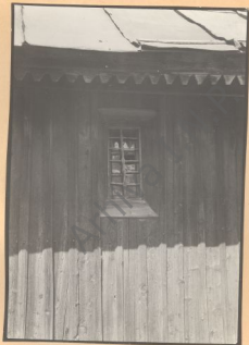
1. Detaliu. Ferestra meridională a proscosului. Grăbia ferestrei e de lemn (imitație după fier)
