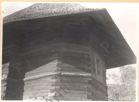
1. Absida altarului dintr-un sud-est cu detaliul bîșului care trece de pe o grindă pe alta
