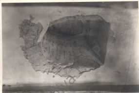
1. Firida de lângă clopotnița. Se vede: arcul de cărămidă Stratul original de tencuială ciocănit ca să prindă stratul nou de tencuială, care s-a dat jos cu ocazia restaurării.
