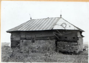
1. Vederea fațadei nord. O mare parte din grinzi a fost înlocuită cu zid de piatră tencuit. La jumătatea înălțimii, îndreptul pronosolului, capătul celor 3 grinzi ce poartă acșasul.
