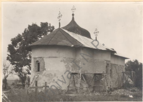
1.(1274) Vedere dinspre nord-est în timpul restaurării din 1929
