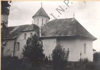
1. Fațada sud 31a
