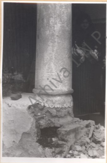
1.Coloana pridvorului,Dezajarea bazei cu ocazia lucrărilor de restaurare
