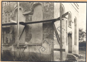
1. Colțul de vest, în timpul lucrărilor. Se vede construcția coloanelor și a stîlpului de unghi din piatră alternată cu straturi de cărămidă
