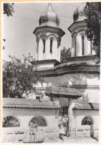
1. Vedere dinspre sud-est
