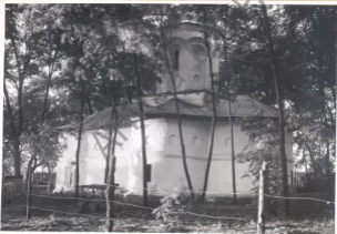
1. Vedere dinspre sud-est
