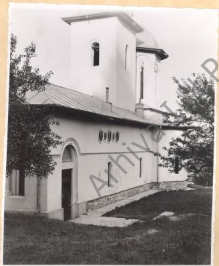
1. Vedere dinspre sud-vest
