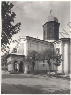
1. Vedere dinspre sud-vest
