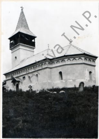
(5) (1277) Fațada sud-est, după restaurarea din 1928.
