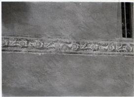
(8) (1277) Fațada sud. Decoratie în frescă
