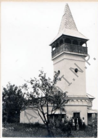
(2). (1277) Fațada vest după restaurarea din 1928.
