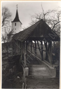
1. Scările acoperite și fațada vest.
