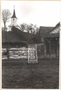
1. Vedere ansamblu din spate vest
