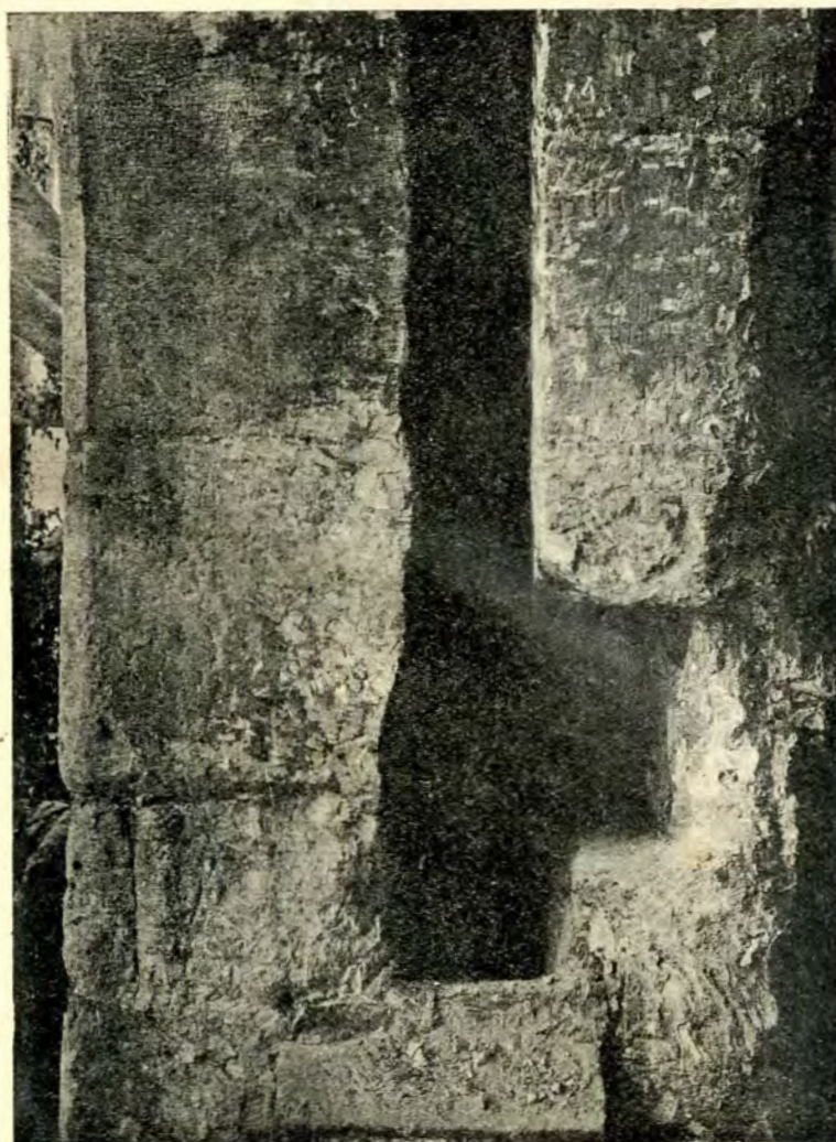
Fig. 5. — Clopotnița mănăstirii Sfântul Gheorghe din Suceava. Piciorul Est al arcadei dela intrare, după înlăturarea tencuelilor în 1939. Se vede șanțul porților culisante și locașul bârnei de baricadare. Jos apărătoarea de roți, pusă în 1910. Clișeul autorului.
